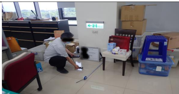
避難方向指示燈移位設置照片
