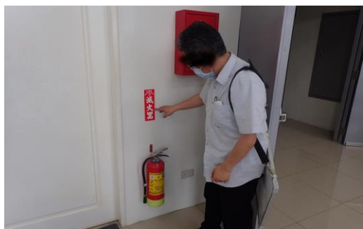
加設滅火器照片
